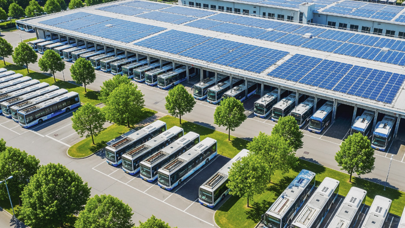
Abb. 1: E-Bus-Depot mit Photovoltaikanlage und Batteriespeicher.
